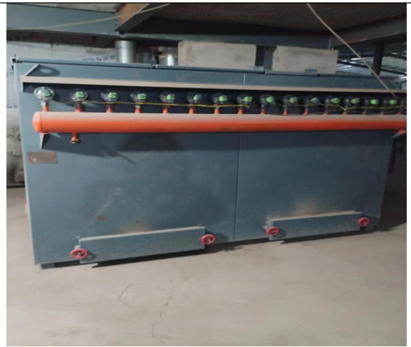
生物质热风炉废气处理装置+排气筒
